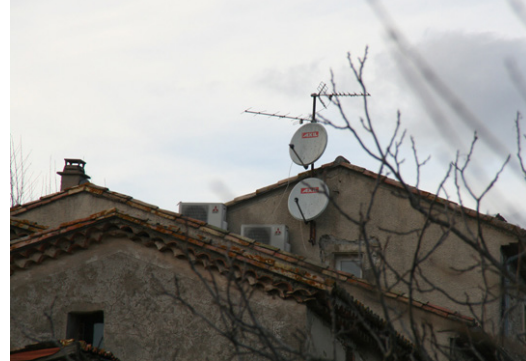
des éléments techniques mal positionnés
