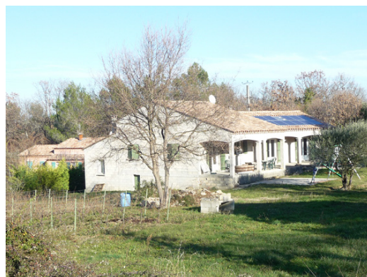
Panneaux photovoltaïques en toiture
