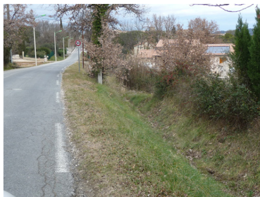
fossé route de Vézénobres
