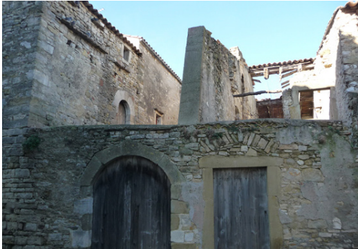
des bâtiments à l'abandon
