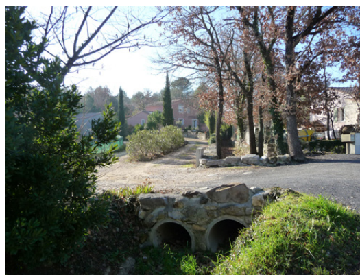
passage sur fossé
