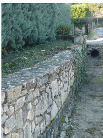
fossé avec mur en pierres
