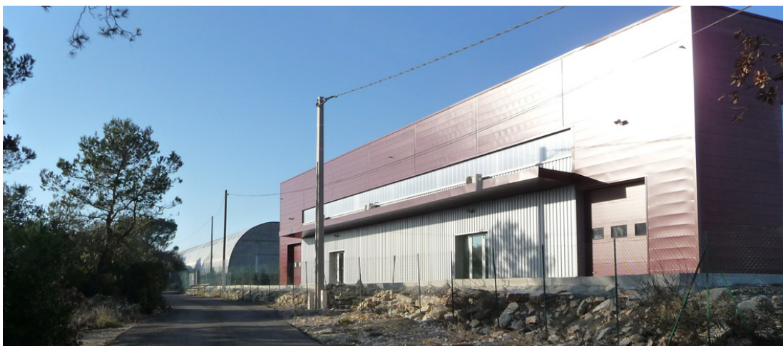
Bâtiments de la zone de l'aérodrome masqués depuis la départementale ou le village par les boisements de pins
